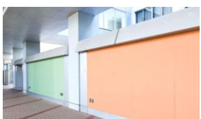
架空连廊和公告栏 C馆前
